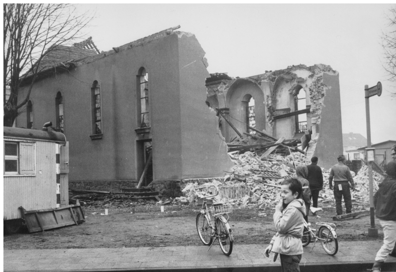
Abbruch der alten Kirche 1973
