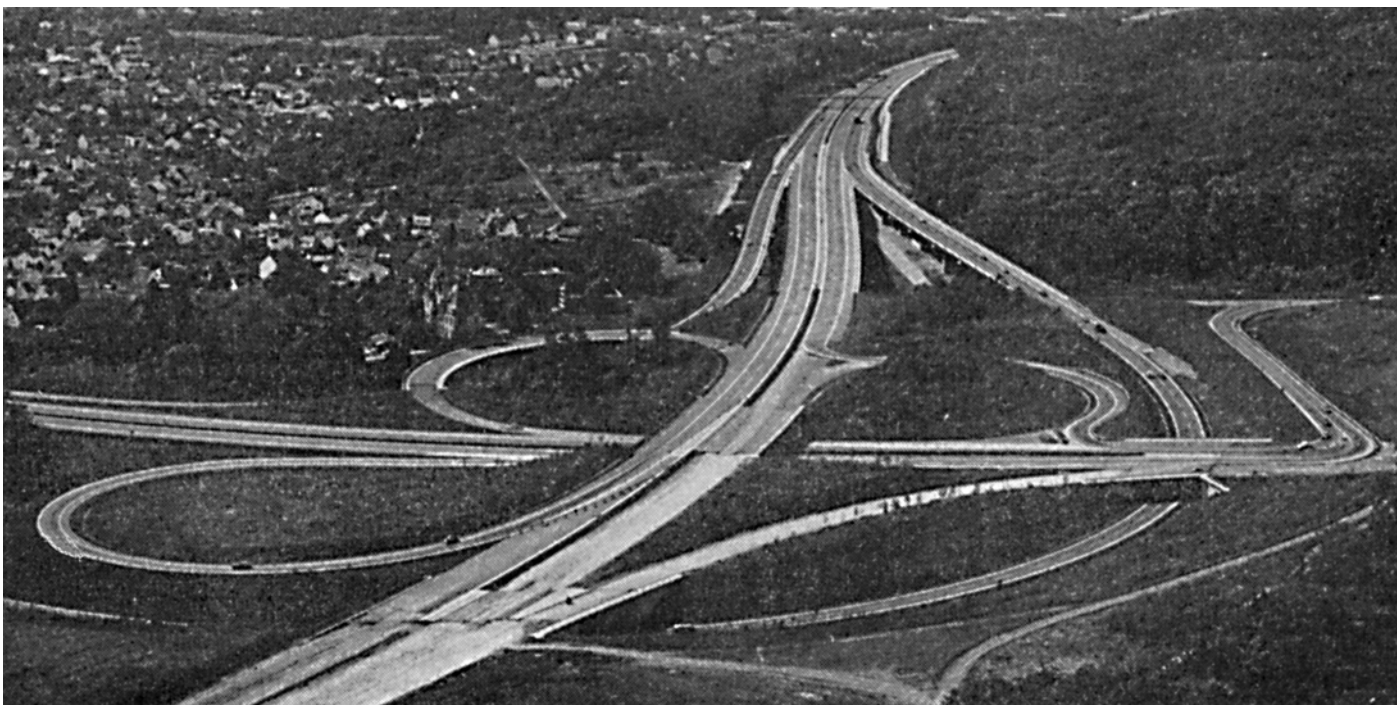
Lange wird es noch dauern, bis der Verkehr auf den Anschluss zur Südtangente (rechts im Bild) rollen kann.
