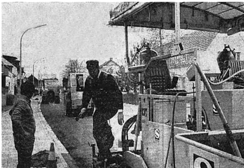
Nach einigen Anfangsschwierigkeiten läuft der Ausbau der Löwenburgstraße auf Hochtouren
