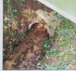
Bislang fließt der Holtorfer Bach teilweise im Rohr. FOTO: STAAT BONN
